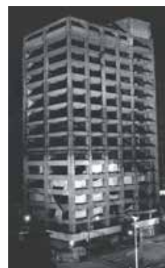
SANTIAGO SIERRA Edificio iluminado, calle Arcos de Belén n.º 2 Mexico. August 2003 , 2005 Fotografia b/n 246 x 150 cm
