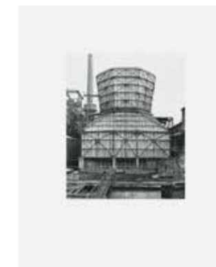
BERND AND HILLA BECHER Kühlturm, Stahlwerk Hagen-Haspe 1969 [Torre de refrigeració, Fundició d'acer de Hagen-Haspe 1969], 2002 Fotografia. Impressió triplex sobre cartró 74 x 60 cm
